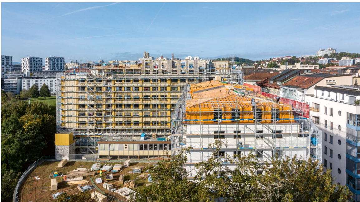
Baustelle in Fribourg: Sanierung und Aufstockung Rue Jacques Vogt 1–3 und Boulevard de Pérolles 32–34
