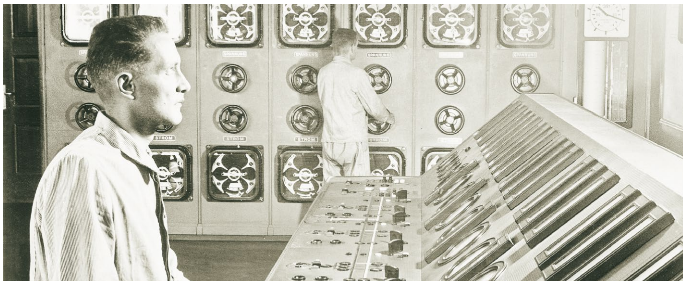
Kommandoraum des Kraftwerks Gösgen. Das 1917 erbaute Kraftwerk ist mit einer Jahresproduktion von rund 300 Mio. kWh heute eines der grössten Laufkraftwerke an der Aare. Die Personen auf dem Bild waren bereits bei der Pensionskasse Schweizerischer Elektrizitätswerke (heutige PKE) versichert. (Fotografie um 1921, Alpiq AG.)
