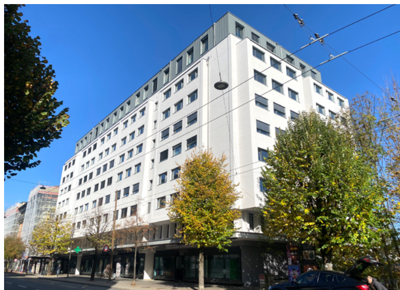
Risanato e sopraelevato: l'immobile della CPE a Friburgo, Rue Jacques-Vogt 1-3 e Boulevard de Pérolles 32-34
