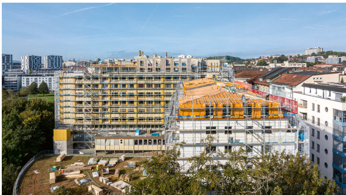
Chantier à Fribourg: Rénovation et surélévation, rue Jacques Vogt 1–3 et boulevard de Pérolles 32–34
